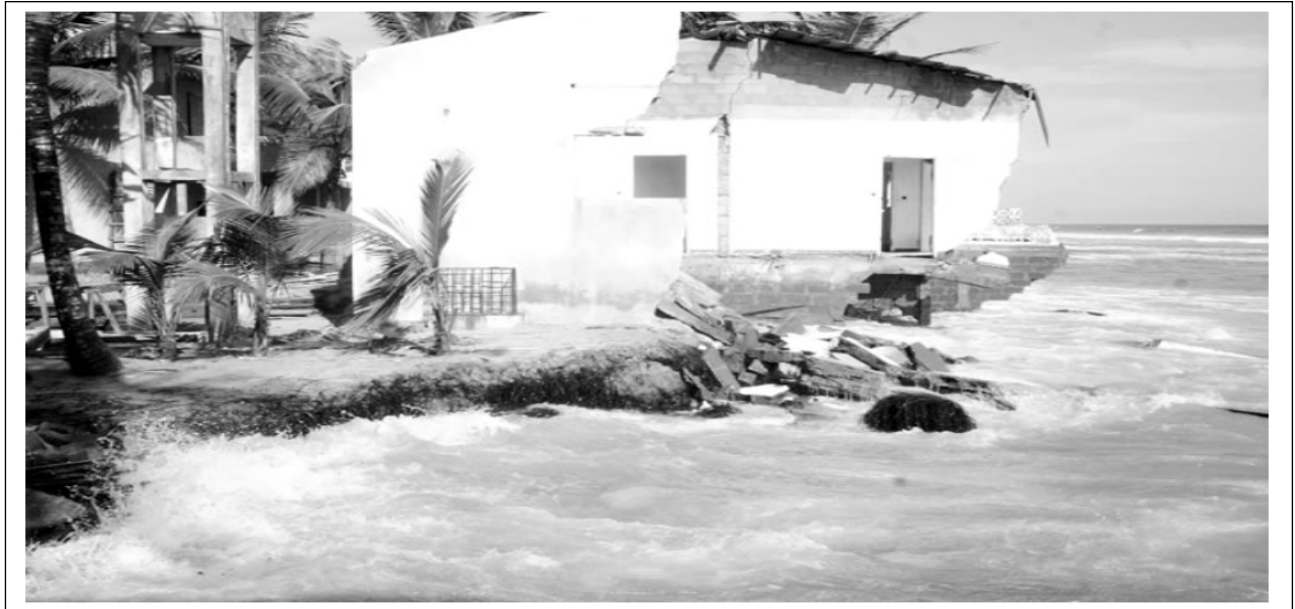
Figure 3. Ruines d'une maison détruite par la mer (Moussa, 2008).
